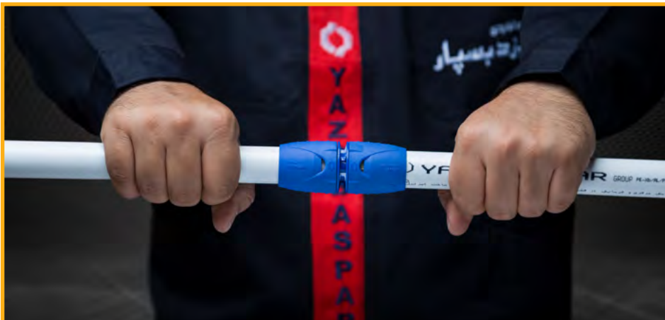
نحوه نصب لوله‌های یزد پکس
